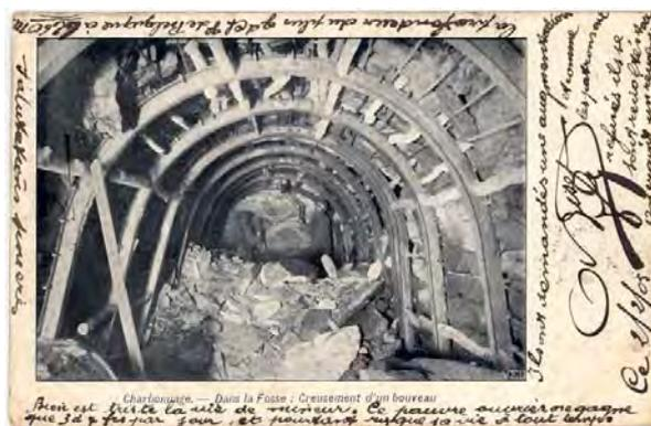
Fig. 10 : Charbonnage - Dans la fosse : Creusement d'un bouveau.
