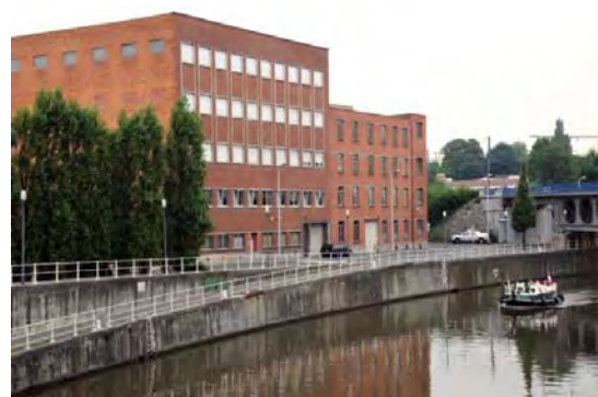
Fig. 5 : Vue des Archives de l'État à Bruxelles (Anderlecht).
