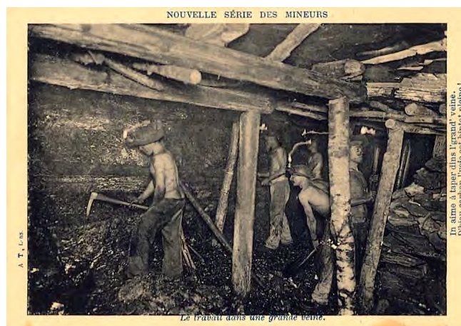
Fig. 6 : Nouvelle série des mineurs – Le travail dans une grande veine. Cette vue, comme la vingtaine qui composent cette série, est légendée par quelques vers du poète mineur Jules Mousseron. Elle est mise en scène dans un chantier au fond de la mine. Le cliché a été pris selon la méthode dite "open flash". Une fois les mineurs ayant pris position, l'appareil est mis en pose dans l'obscurité et le coup de flash au magnésium déclenché pendant la pose. On distingue très bien la trace des flammes de lampe sur le cliché lorsque le mineur a bougé pendant le temps de pose. Carte postale non écrite, Édition Alexandre à Lens - Coll. P.-C. Guiollard.
