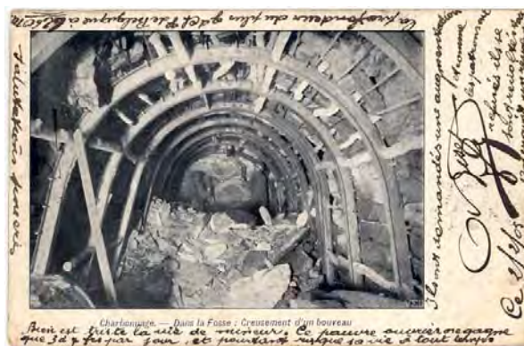
Fig. 10 : Charbonnage - Dans la fosse : Creusement d'un bouveau.
