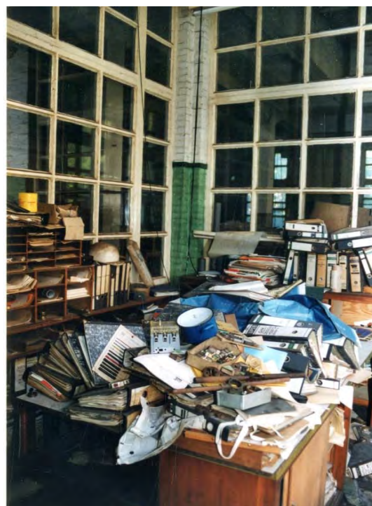
Fig. 3 : Les locaux de la SAFEA à l'abandon, 2003 (coll. AVCLL).
