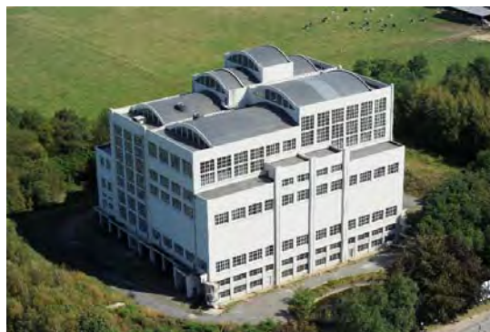
Fig. 19 : Site du Triage-Lavoir de Péronnes, après restauration – Photo Guy Focant © SPW_Patrimoine.
