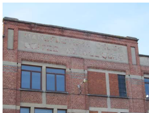
Fig. 2 : Pignon de l'ancienne "Manufacture belge de boîtes métalliques". Cette usine fabriquait des boîtes à conserve, dans les quartiers des Abattoirs d'Anderlecht.
