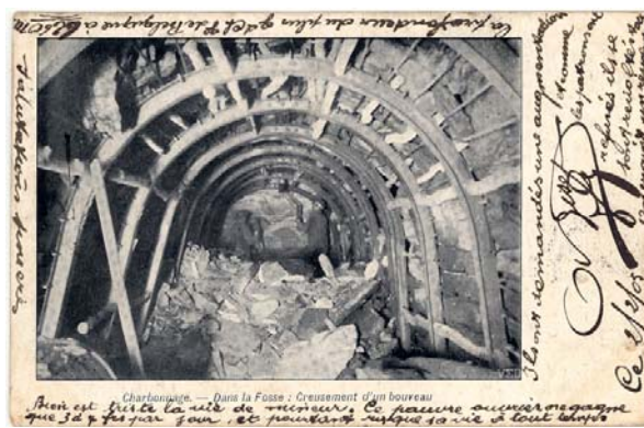
Fig. 10 : Charbonnage - Dans la Fosse : Creusement d'un bouveau.
